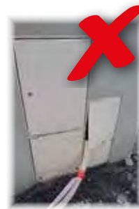
SANS sur-plinthe de réalimentation
