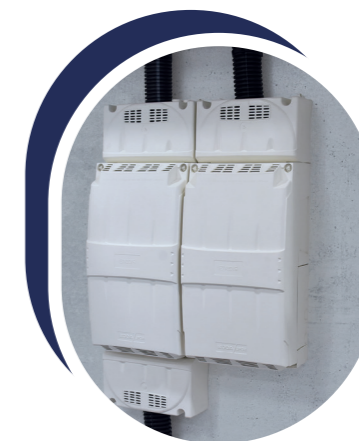
SPCM placés dans un parking comportant 2 travées
