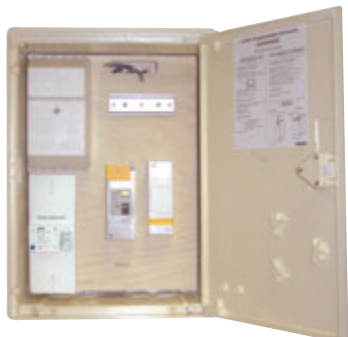
Coffret de branchement provisoire monophasé (P490 - P489)
