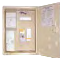
Coffret de branchement provisoire monophasé (P490 - P489)
