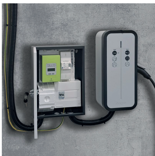
Ci-dessus : exemple d'armoire de comptage ParkBox start Michaud associée à une borne de recharge. Dans l'armoire, nous voyons le compteur Linky individuel.
