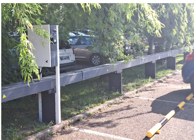
Exemple de desserte en élévation avec le système ParkBridge Michaud.
