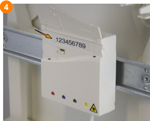
Poser les étiquettes d'identification sur le capot (une étiquette collée sous la trappe et l'autre collée à l'intérieur du capot).
