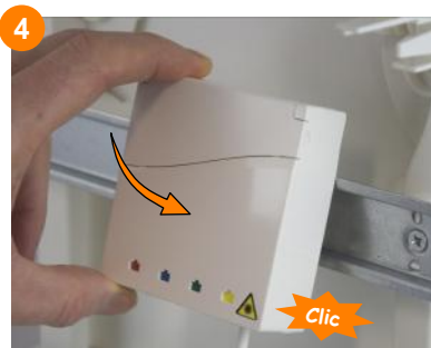
4 Clipper le DTIo sur le rail DIN dans le coffret. Le DTIo peut également se clipper avec les sorties orientées sur le côté.
