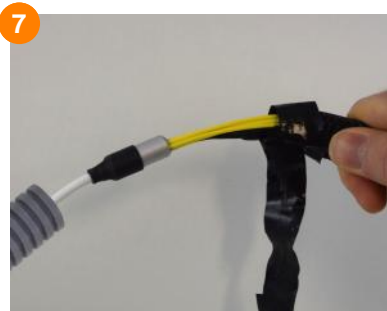
7 Pour un kit préconnectorisé, après avoir récupéré la chaussette de tirage à la sortie du conduit (ø25 mm mini), retirer l'adhésif et dégager la zone de séparation des fibres en tirant la gaine. Couper le tube noir puis retirer intégralement la chaussette pour récupérer la ou les fiches connectorisées en usine.
