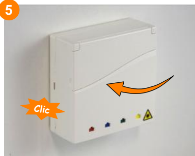
5 Une fois que le câble est entièrement passé, clipper la PTO sur la platine.
