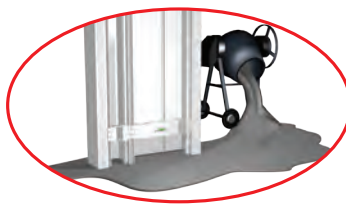
3. Rigidifie la goulotte lors du coulage de la chape
